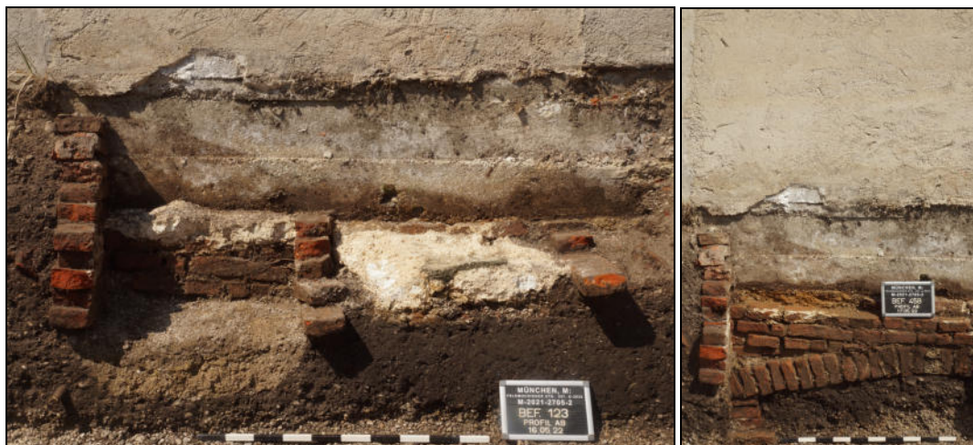
Abb. 6 Links: im früheren 20. Jh. an das Fundament des 1908 abgerissenen Pfarrökonomiegebäudes gesetzte Kalkgruben. Rechts: dahinter das materialsparend mit Hilfe von Entlastungsbögen konstruierte Fundament des im 18. Jahrhundert errichteten, 1908 abgebrochenen Baus. Hierauf fußt die rezente Betonmauer
