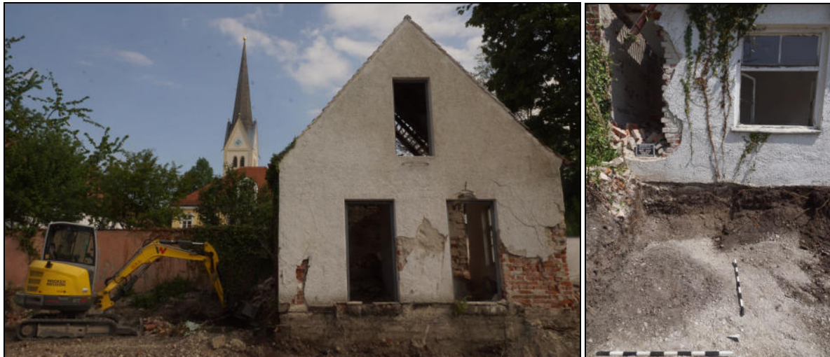
Abb. 1 Befundbearbeitung um das bereits entkernten Nebengebäude .
