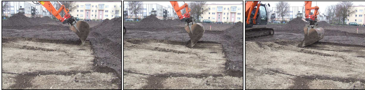
Abb. 1 Oberbodenabtrag mit dem Kettenbagger. Die Rotlage wird bis auf den gewachsenen Kies abgezogen.
